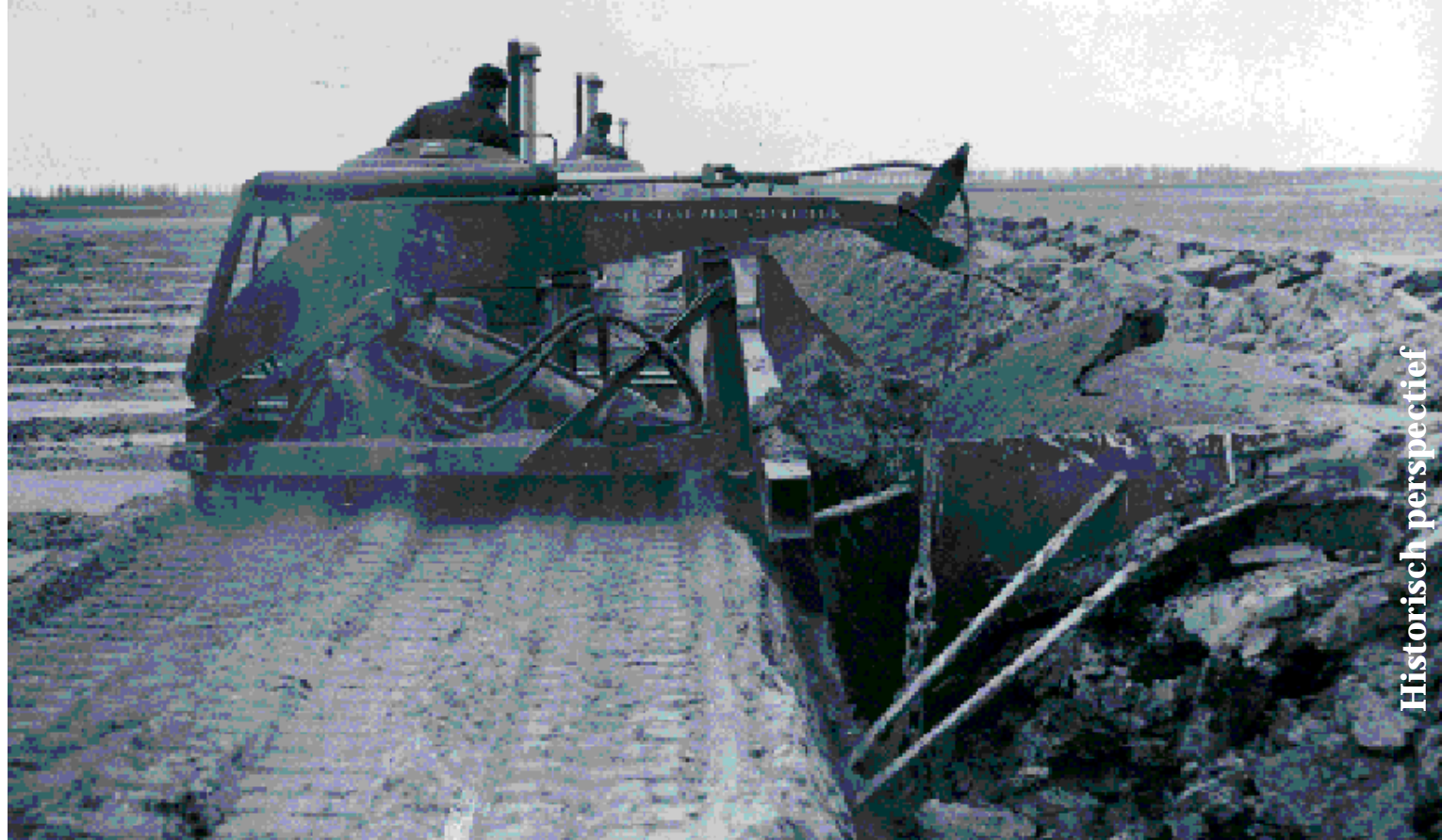
Nieuw land wordt bouwrijp gemaakt met een diepploeg. Om de structuur van de grond te verbeteren wordt tot wel een meter diep geploegd (1954).
